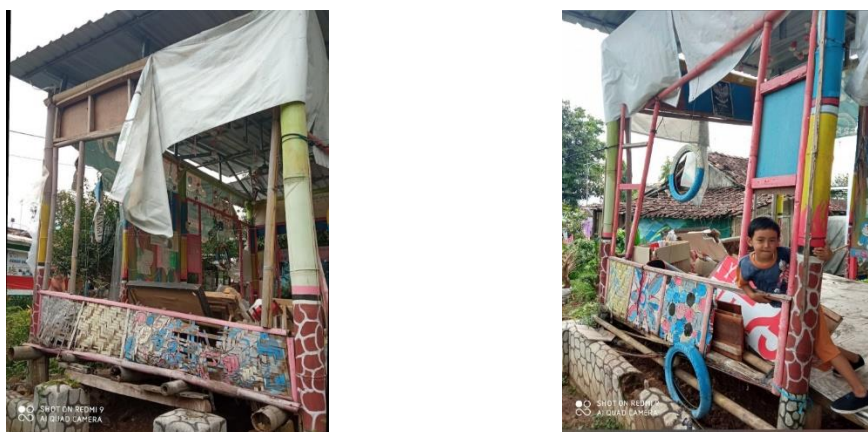
Gambar 1. Ruang TBM Soka Sebelum Direnovasi
