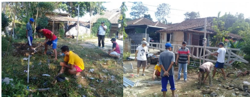
Gambar 4. Pembersihan Lahan dan Pemasangan Rangka
