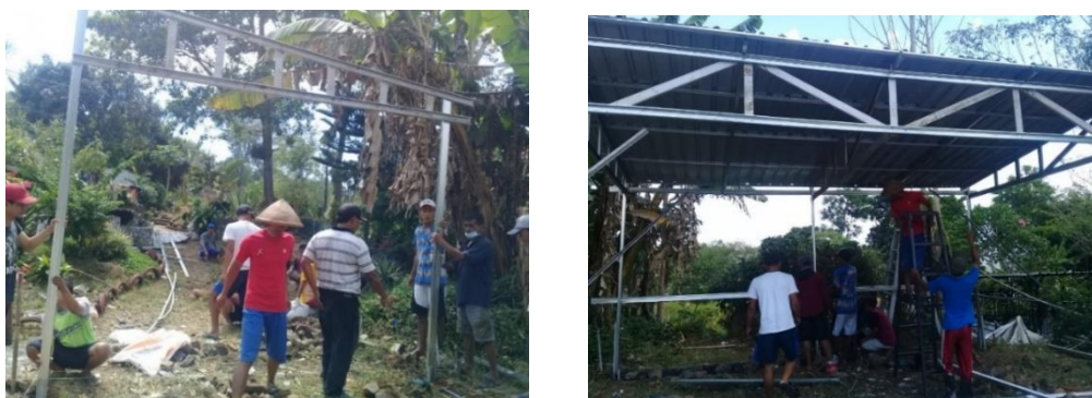
Gambar 5: Pemasangan Tiang Rangka & Atap
